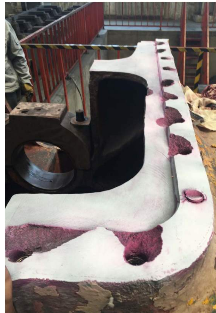
机身顶盖螺栓孔均已损坏
