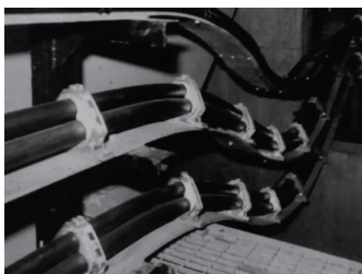
英国利河桥132kV电力电缆敷设
