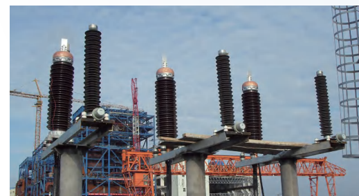
国网杭州-卢双1928线、郭屿3151线改造项目
