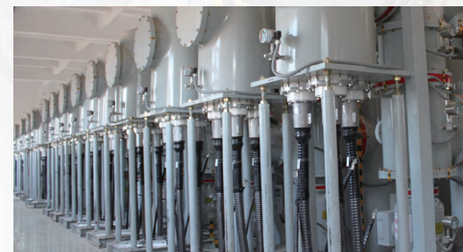
110kV纵横集团丰南钢铁项目
