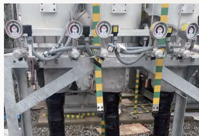
眉山市通威太阳能四期新建工程
