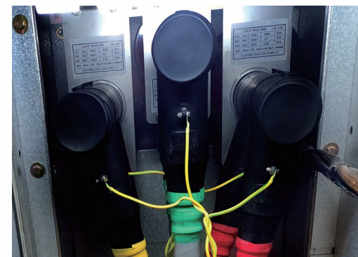
中联数据220kV变电站10kV扩容改造项目
