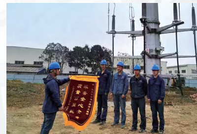
四川杉杉220kV输电线路工程
