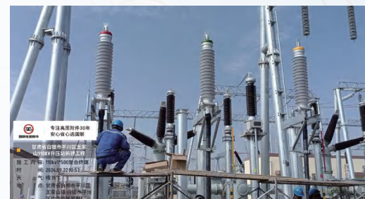
甘肃省白银市平川区王家山110kV升压站新建工程
