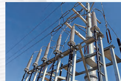
秦淮大数据中心送出项目
