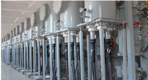
110kV纵横集团丰南钢铁项目
