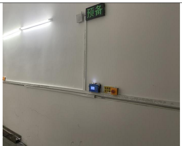
图9 固定式场所辐射探测报警装置
