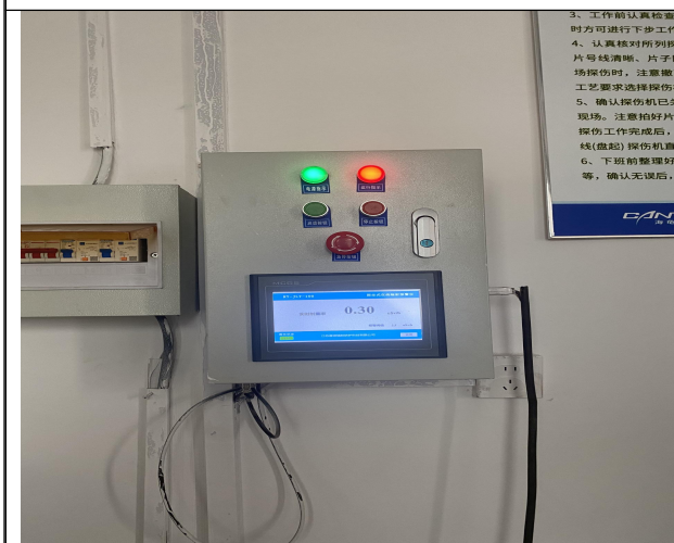
图9 固定式场所辐射探测报警装置
